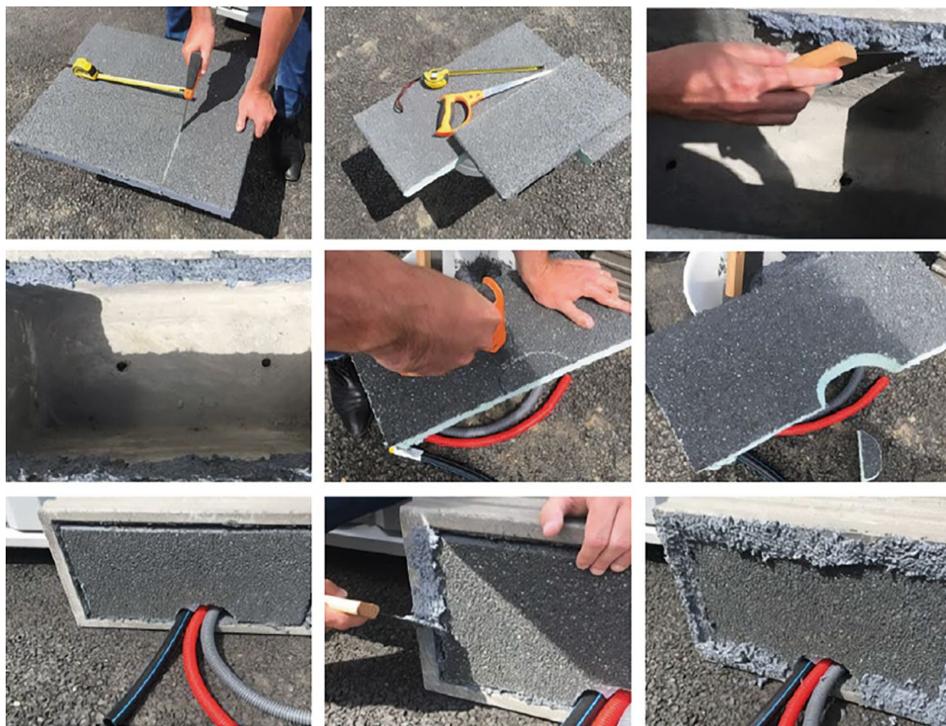
Bei ganz großen Löchern kann eine Polyurethan-Platte der PFP-Reihe, ähnlich einer Wärmedämmplatte, entsprechend zugeschnitten werden.
