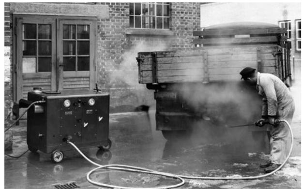
**Das erste Reinigungsgerät von Kärcher: der erste europäische Heißwasser-Hochdruckreiniger KW 350 aus dem Jahr 1950.**
